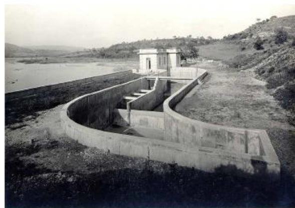
Opera di Presa sul fiume Sele
