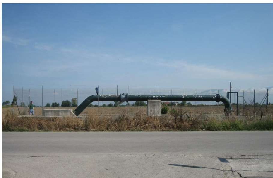
Cavallotto esistente di consegna ai reparti irrigui
